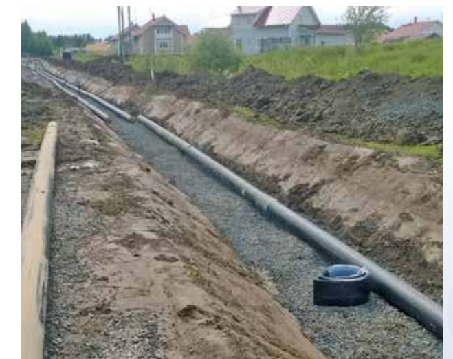
Kaukolämpöverkoston rakentamista Pirkkiössä
