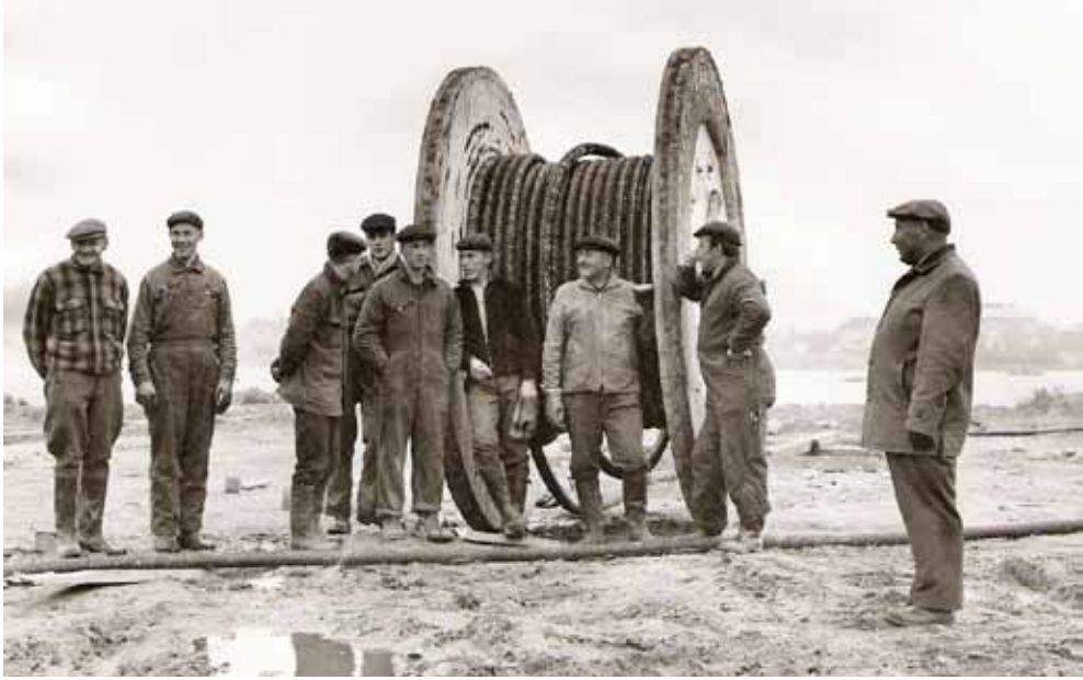
Merikaapelin asennustyötä vuonna 1962. Kuvassa vasemmalta: Janne Mäkimaa, Eero Rantajärvi, Raimo Virtanen, Esko Pelttari, Ossi Huhtalo, Erkki Jurvelin, Viljo Mattinen, Veikko Kari ja Veikko Tervo. ”Suurten kaapelikelojen liikuttelu oli vaikeaa. Muuntajaa liikuteltiin kallistelemalla puolelta toiselle. Tervo oli hyvä keksimään tapoja siirrellä raskaita laitteita”, Veikko Kari muistelee.
