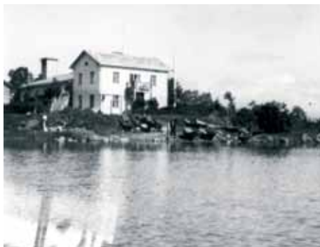
Sotatilan vuoksi jouduttiin sähkölaitoksen ikkunoiden eteen kiinnittämään sirpalesuojat vuonna 1940.
