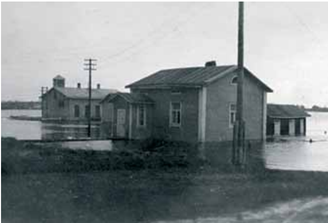
Sähkölaitos ja johtajan asunto kevättulvan aikaan vuonna 1924.
