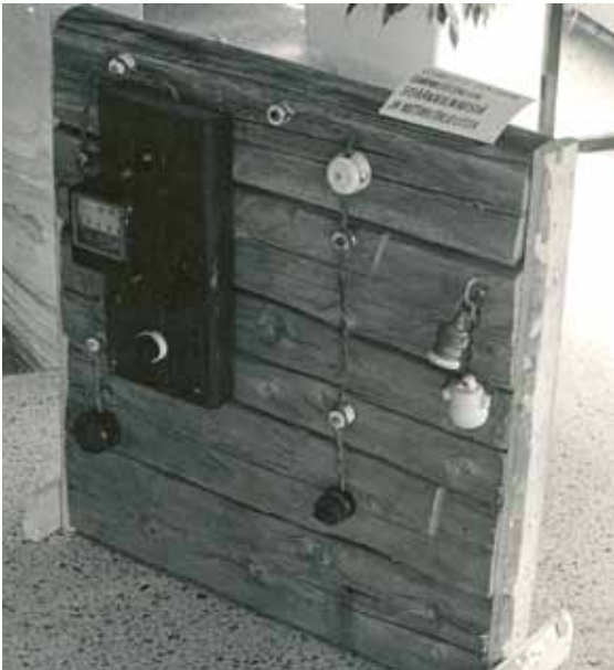
Sähkölaitoksen 75-vuotis juhlanäyttelyssä esillä oli kappale vanhan omakotitalon seinästä, jossa näkyy johdon sisäänvienti ja mittaritaulu.
