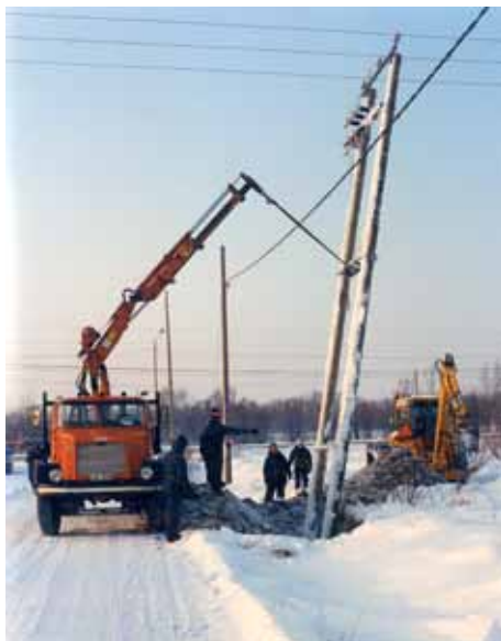
Muuntajapylvään paikalleen nostoa talviaikaan. Apuna työssä sähkölaitoksen auto.
