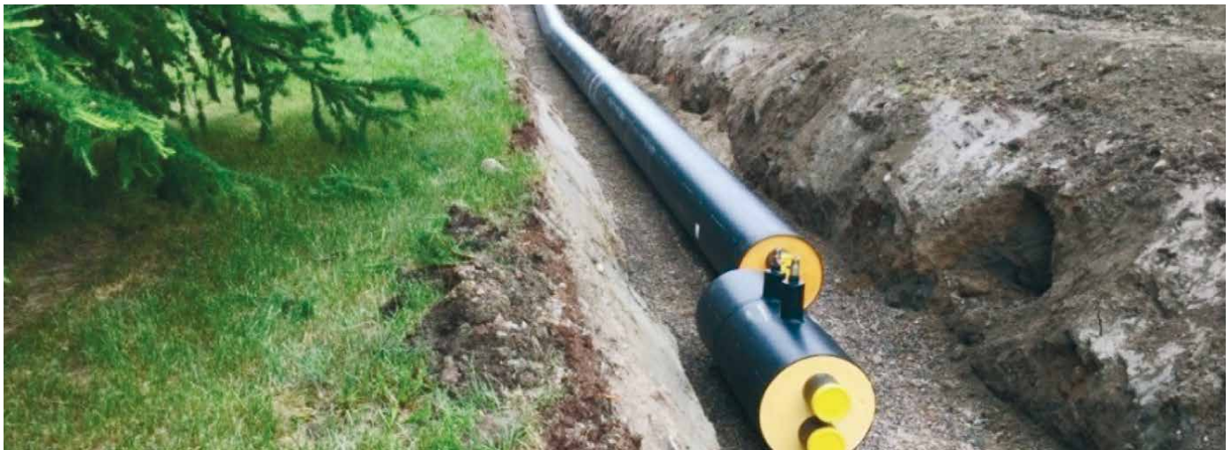
Kivirannalle kaukolämmön toimitusvarmuutta putki DN 150 Mpuk + sulkuventtiili.
